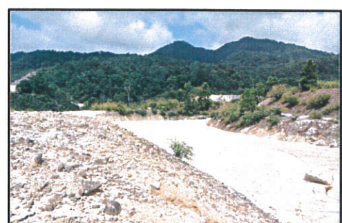
(24) อ่างตกตะกอนที่ 9 ข้าง โกล์หน้าเหมือง 5E ขนาดความจุ 2,500 ลบ.ม.
