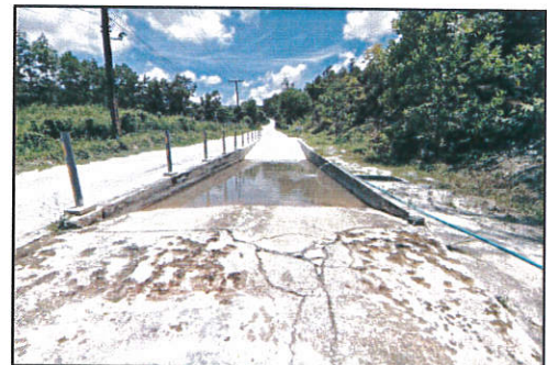
(6) บ่อล้างล้อรถบรรทุกก่อนจากพื้นที่โครงการ
