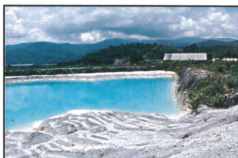
(16) อ่างดักตะกอนบริเวณลานสต็อกวัดถุดิบ (อ่างดักตะกอนที่ 1 ขนาดความจุ 8,800 ลบ.ม)
