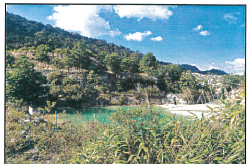
(28) อ่างตกตะกอนที่ 13 ใกล้หน้าเหมือง 2D ขนาดความจุ 10,000 ลบ.ม.
