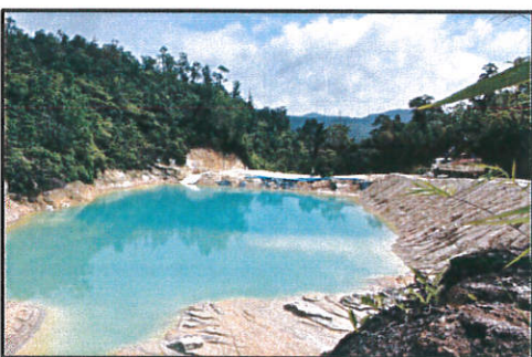
(23) อ่างตกตะกอนที่ 8 บริเวณที่ทิ้งดิน ด.3 ขนาดความจุ 6,000 ลบ.ม.
