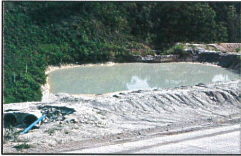
(17) อ่างตกตะกอนบริเวณลานสต็อกวัตถุดิบ (อ่างตกตะกอนที่ 2 ขนาดความจุ 5,400 ลบ.ม)
