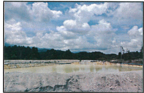
(18) อ่างตกตะกอนบริเวณลานสต็อกวัตถุดิบ (อ่างตกตะกอนที่ 3 ขนาดความจุ 23,375 ลบ.ม)
