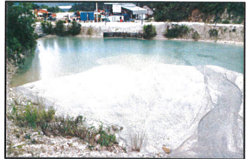
(26) อ่างตกตะกอนที่ 11 ข้าง Stock G ขนาดความจุ 4,900 ลบ.ม.
