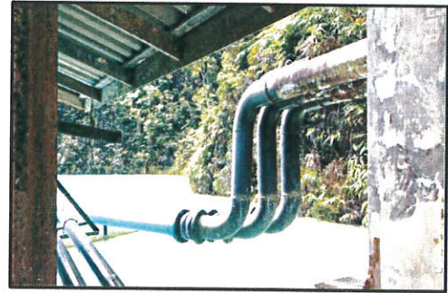
(34) ท่อระบายน้ำจากบ่อดักตะกอนคอนกรีตลงสู่อ่าง เก็บน้ำหมุนเวียน (อ2)
